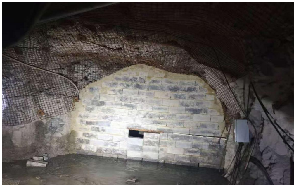
图 4-9 实地调查封闭的采空区密闭
