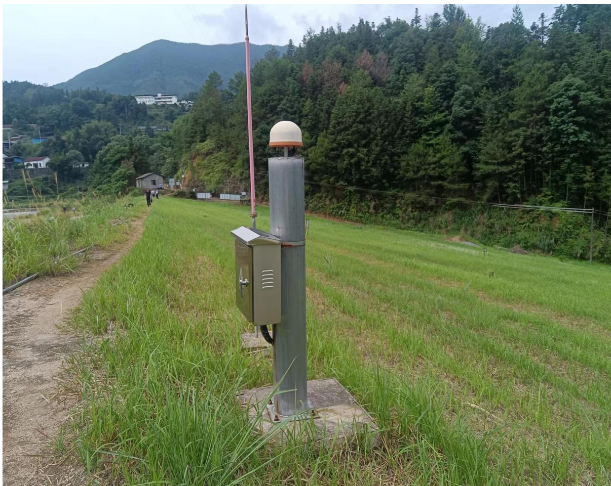
图 2-10 坝体位移观测桩
