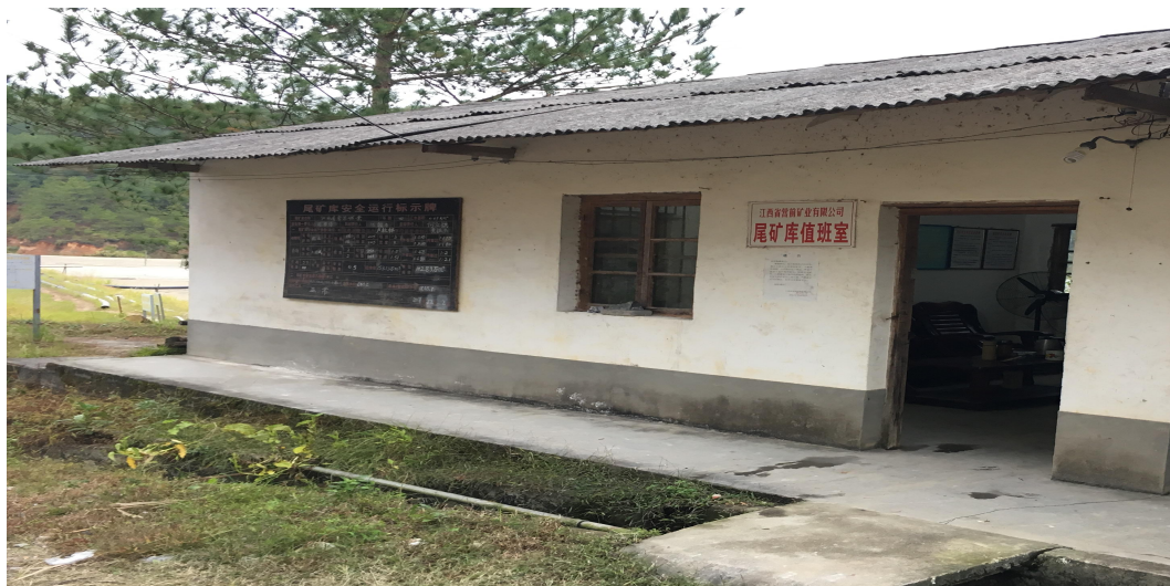
图 2-14 1#尾矿库值班室
