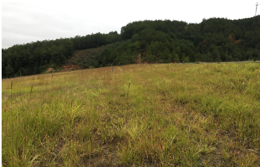
图 2-6 堆积子坝外坡面
