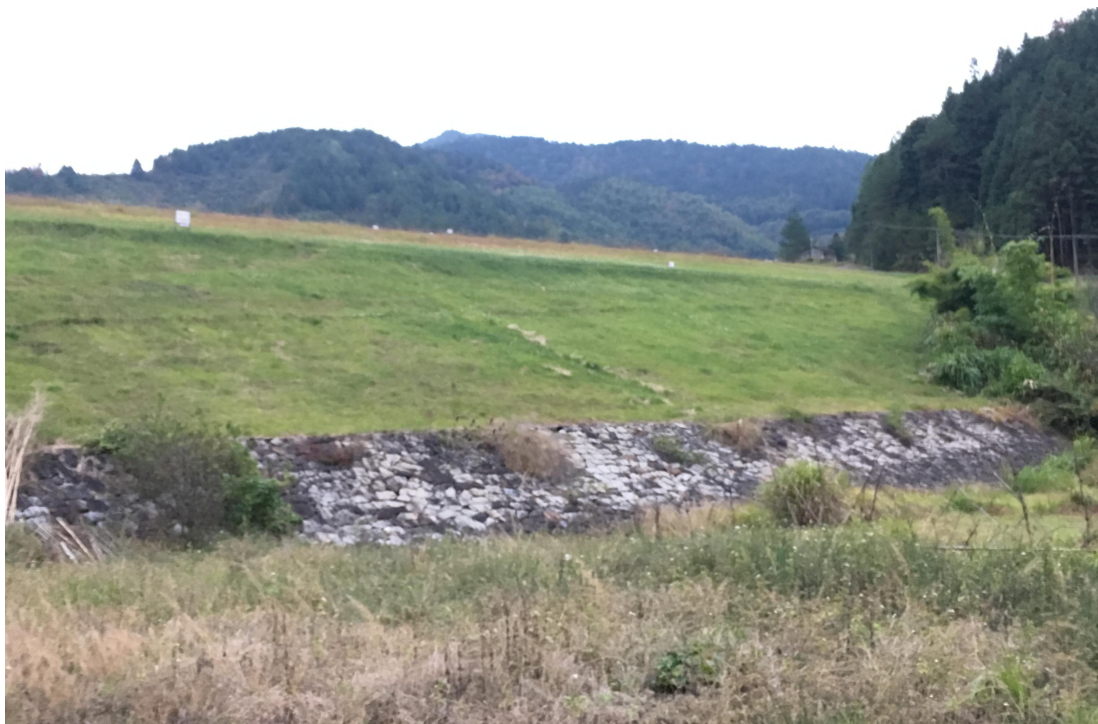
图 2-5 初期坝外坡面
