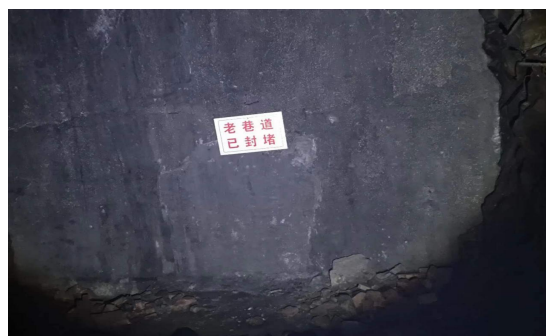
一矿区+50m 中段废弃巷道封堵
