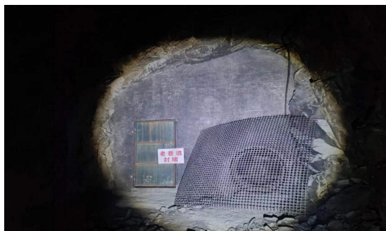
一矿区+100m 中段废弃巷道封堵
