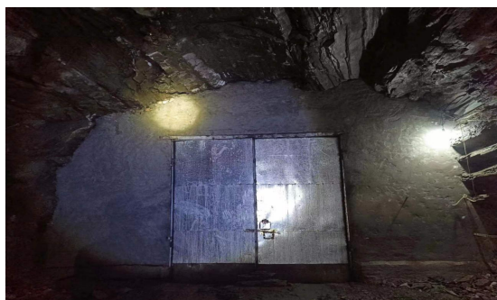
一矿区±0m 中段废弃巷道封堵
